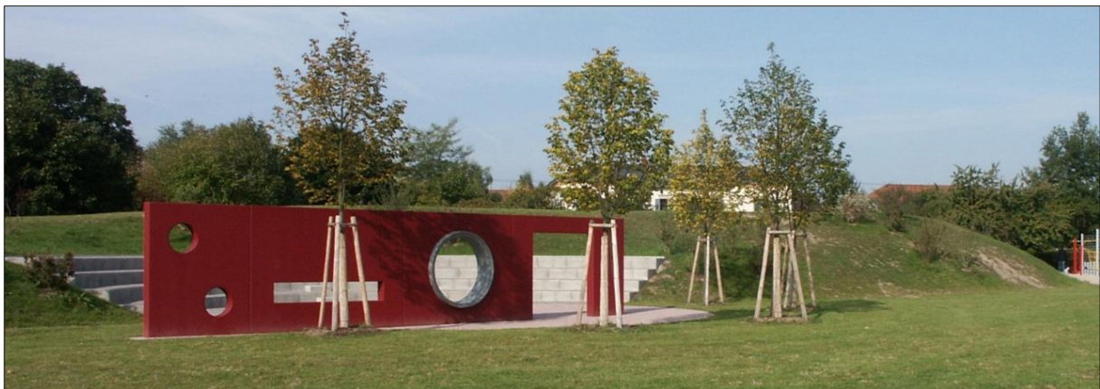
Abbildung 35: Kies-Wasser Erdbecken in Eggenstein. Bildquelle: Universität Stuttgart, Institut für Gebäudeenergetik, Thermotechnik und Energiespeicherung
