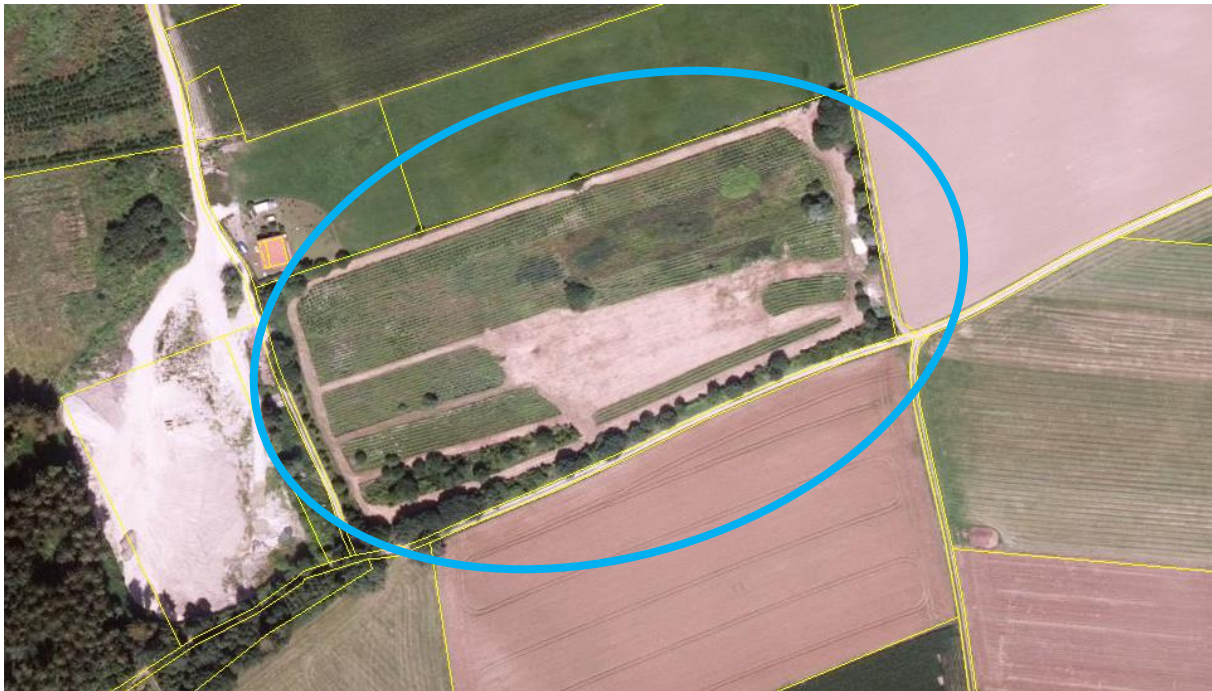
Abb. 4 Luftbild mit Darstellung des Plangebietes (schematisch blau umrandet) – o. M. Quelle: BayernAtlas © 2024 StMFH; Geobasisdaten: © 2024 Bay. Vermessungsverwaltung
