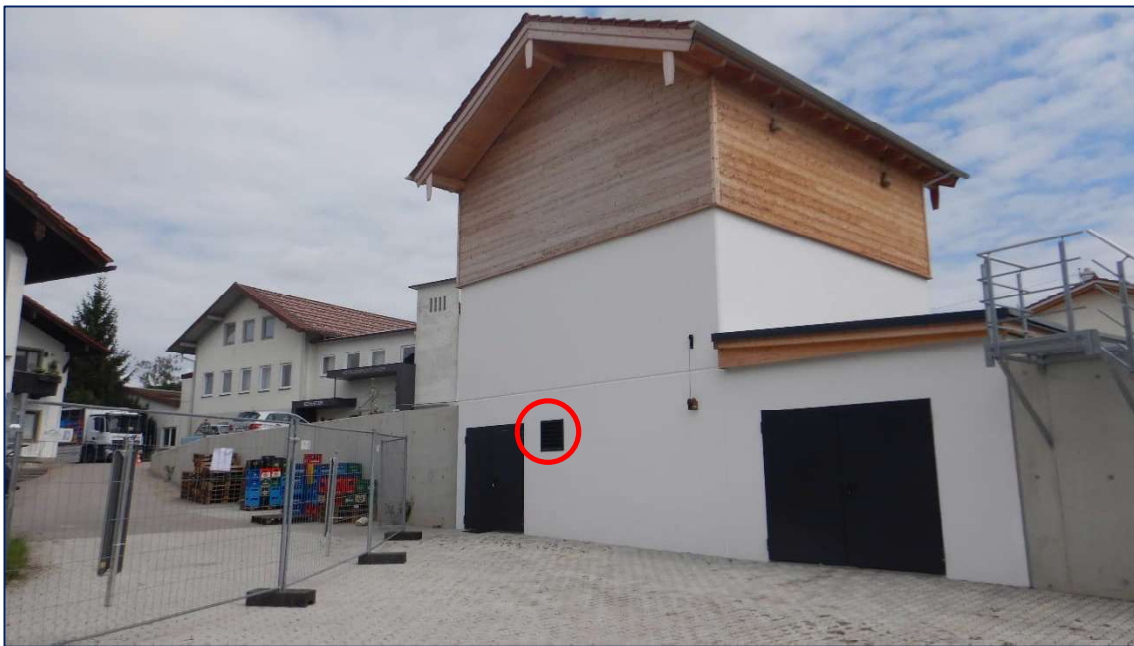
Abbildung 5: Heizwerk mit Kennzeichnung der Lüftungsöffnung (rot)
